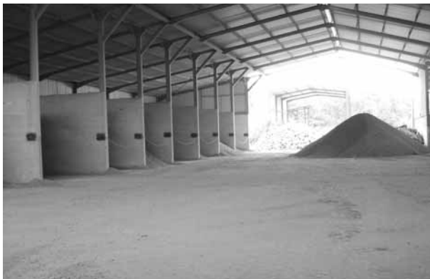
Photo 5. Le hangar de stockage des produits secs (cliché Gérard Sustrac).
